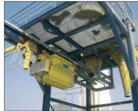
Puerta de descarga adicional add. discharge gate
